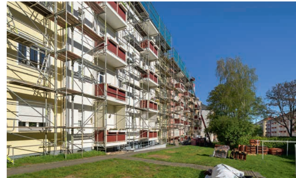
→ Der vierte Bauabschnitt in der Münchner Wohnanlage läuft.
