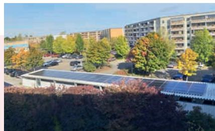
→ Es wurden 96 Module mit 29,9 KWP Leistung montiert.
