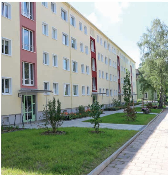
→ An der Bienertstraße ist die Fassadensanierung und die Neugestaltung der Außenanlagen abgeschlossen.
