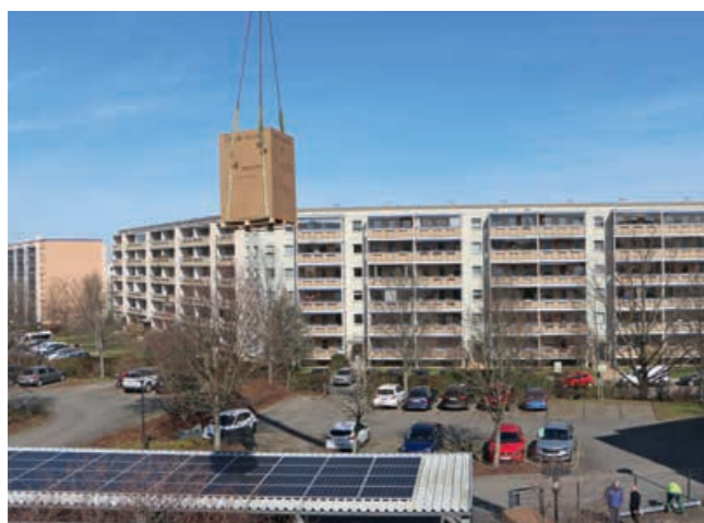
→ Anlieferung der Photovoltaik-Module: Im März wurde am Verwaltungsgebäude die Photovoltaikanlage ausgebaut.
