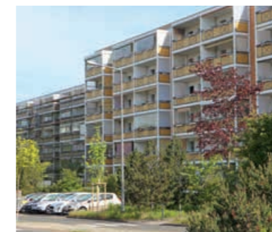
→ Die Georg-Palitzsch-Straße 37–43 (links im Bild mit Gerüst) wird schon bald wie die 45–71 (rechts, ohne Gerüst) strahlen.
