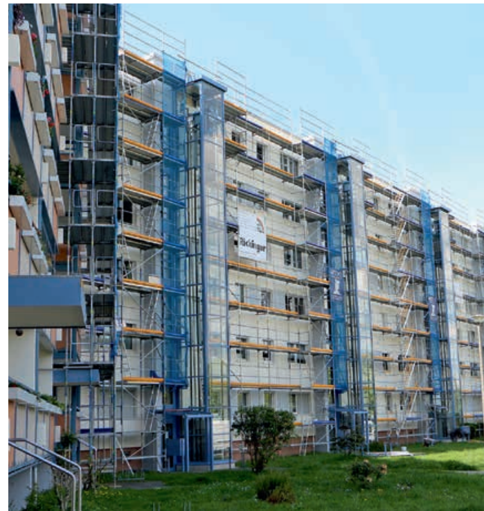
→ Die Cämmerswalder Straße erhält einen neuen Fassadenanstrich.
