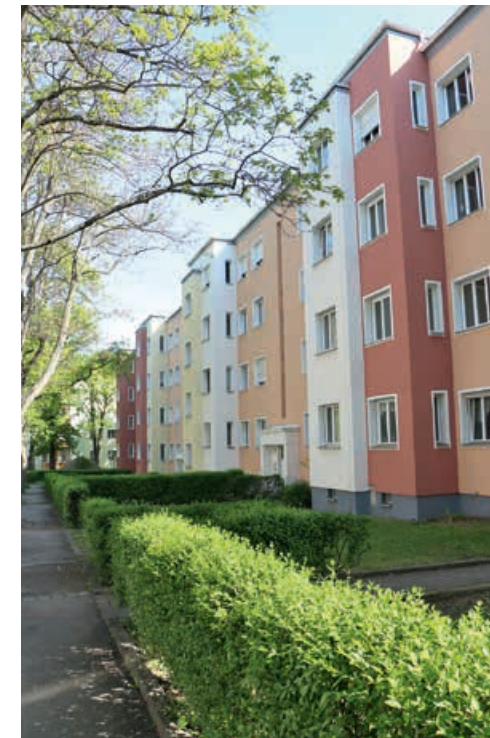
→ An der Regensburger Straße 1 – 7 geht in diesem Jahr die Komplexsanierung weiter.
