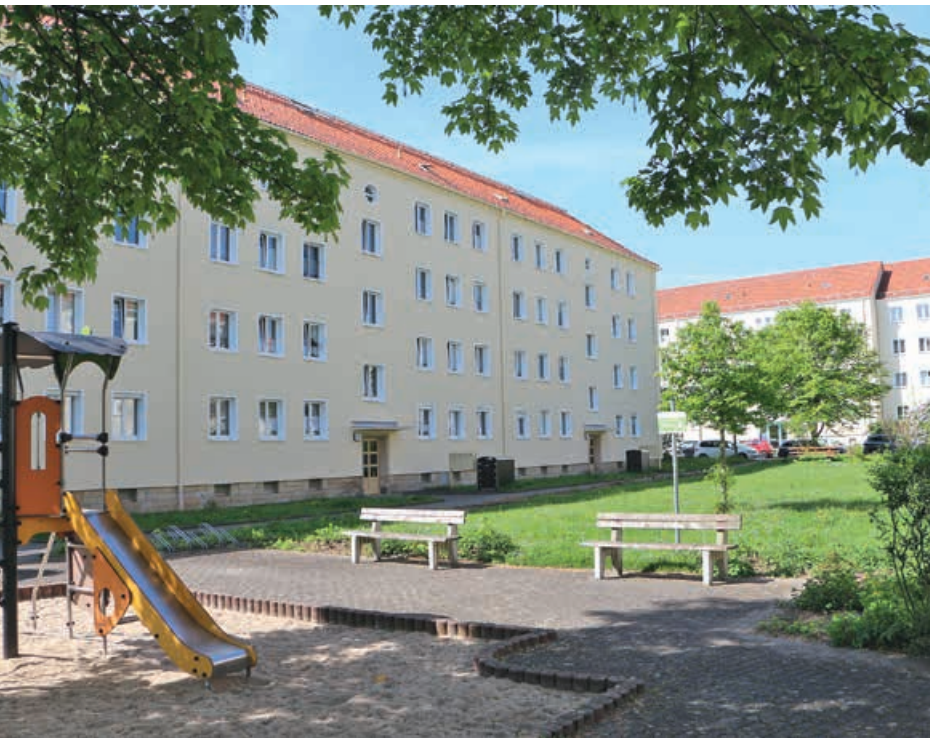
→ An der Bergstraße werden die Außenanlagen neugestaltet.
